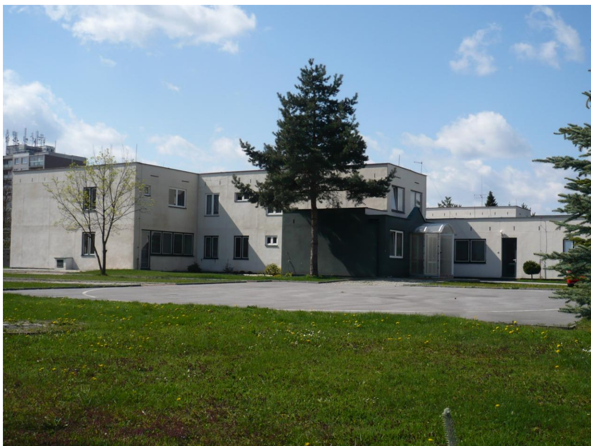
Budova střediska Dědina, o.p.s.
